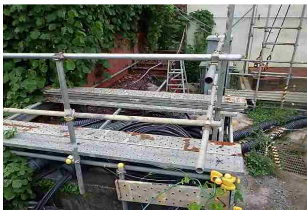
転落防止柵設置完了
